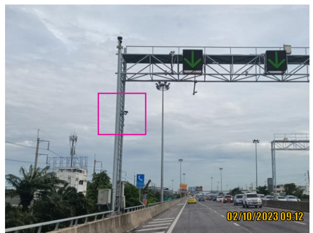
รูปที่ 3.2-13 กล้องโทรทัศน์วงจรปิด ตรวจจับรถวิ่งไหล่ทางพิเศษฉลองรัช
