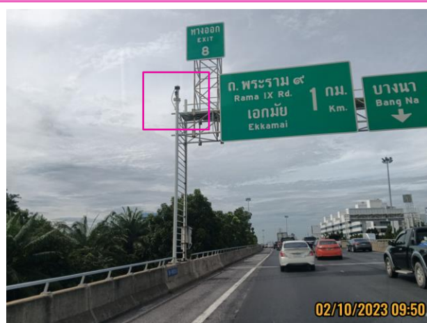
รูปที่ 3.2-12 กล้องโทรทัศน์วงจรปิดดูสภาพจราจร
